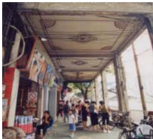
圖 4 - 舊區內典型的騎樓行人通道
