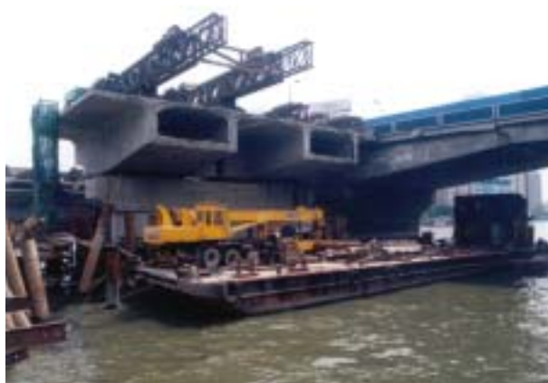
圖 16 - 1998 年興建中之內環路跨越珠江段的人民橋
