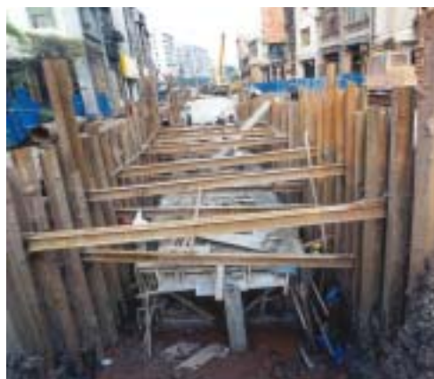
圖 12 - 在舊區的街道加建排污渠道以改善衛生環境
